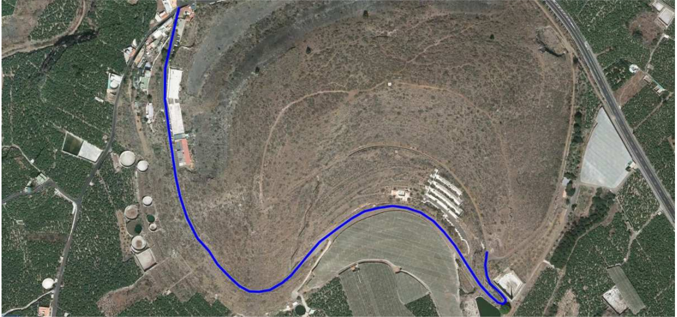
Imagen. Ubicación del acceso a la superficie 4 a restaurar. Fuente: Elaboración propia
